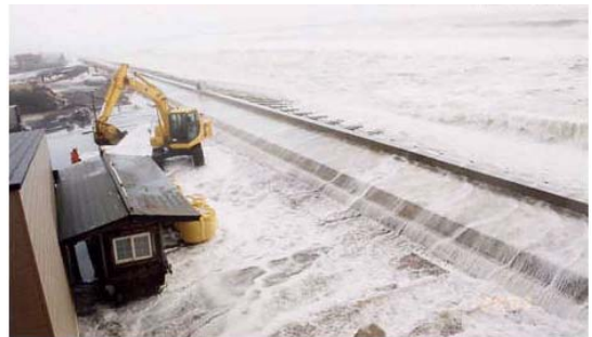
写真-1 越波状況(2003.01.28撮影)
